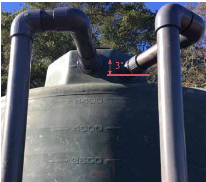
Figura 1-15: Elevaciones de la entrada del tanque y de la tubería de rebose (Fuente: Distrito de Conservación de Recursos de Sonoma)
