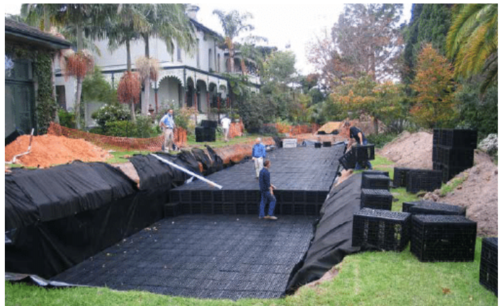
Figura 1-13: Almacenamiento modular enterrado (Fuente: Ausdrain)
