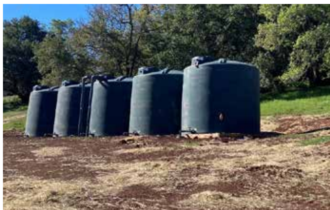
Figura 3-9: Ejemplo de múltiples tanques en la misma elevación (Fuente: Distrito de Conservación de Recursos de Sonoma)
