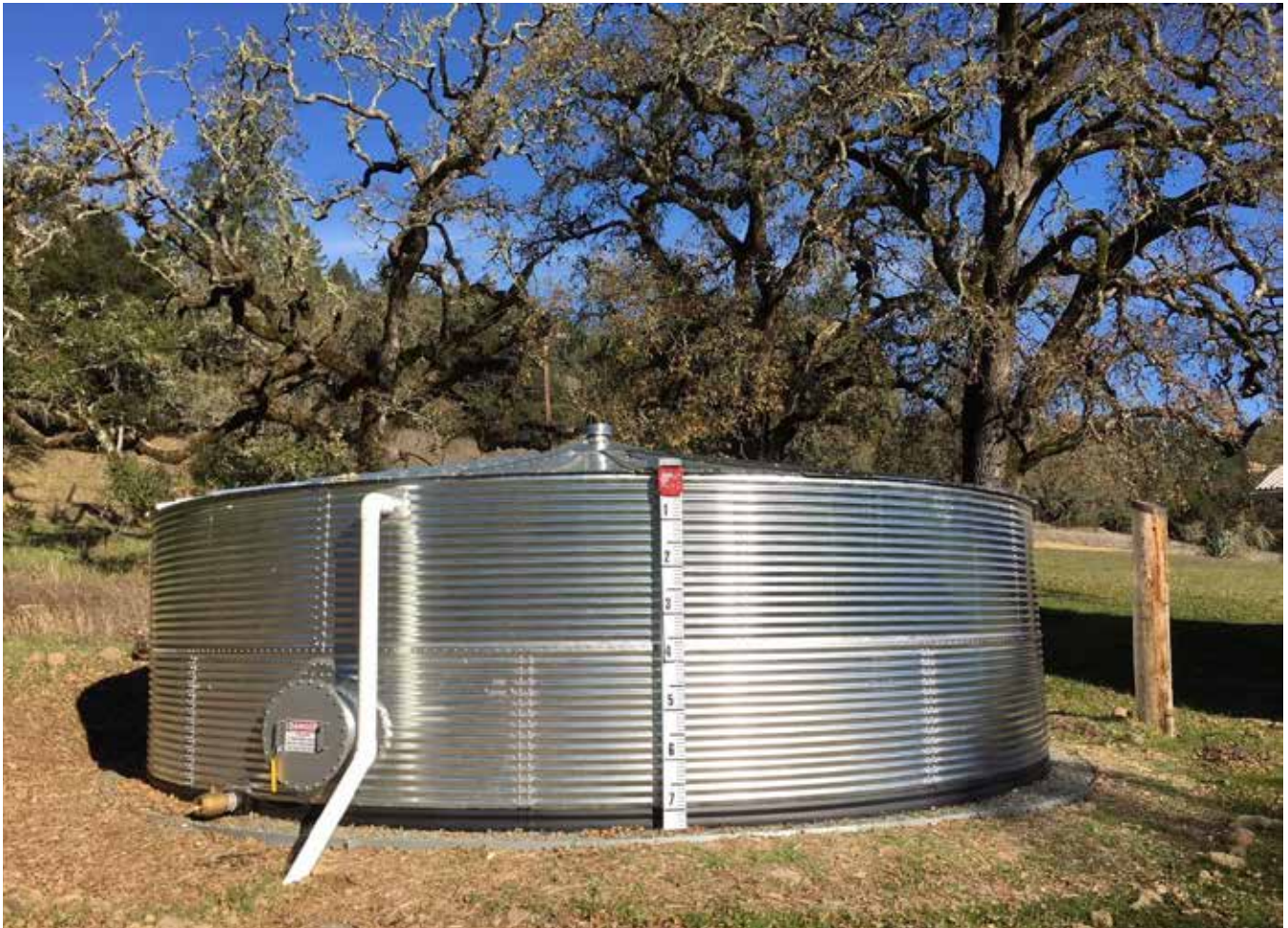
Figura 5-18: Indicador del nivel de agua (Fuente: Distrito de Conservación de Recursos de Sonoma)
