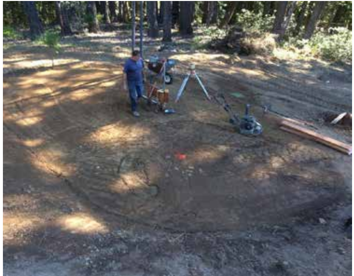
Figura 3-5: Plataforma de tierra nivelada (Fuente: Distrito de Conservación de Recursos de Sonoma)
