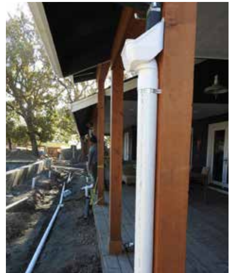
Figura 4-12: Tubería de transporte de línea húmeda con deflector de hojas (Fuente: Permaculture Artisans)
