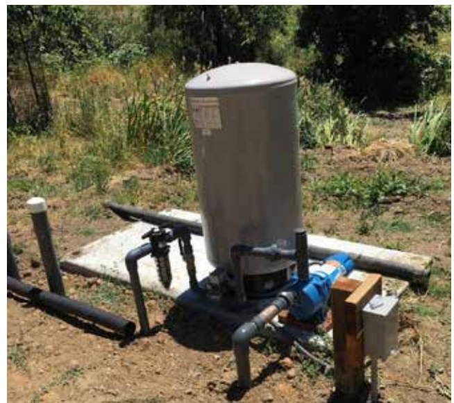
Figura 1-16: Sistema de bombeo típico de un sistema de 10,000 galones (Fuente: Distrito de Conservación de Recursos de Sonoma)
