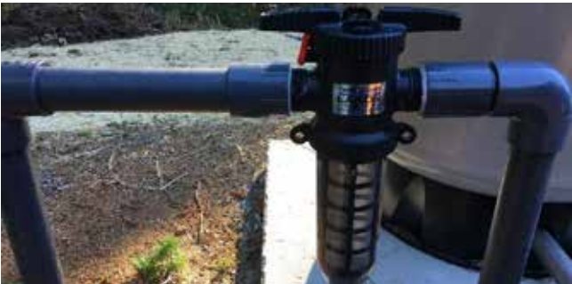
Figura 2-3: Filtro de riego de 100 micras después de la bomba (Fuente: Distrito de Conservación de Recursos de Sonoma)
