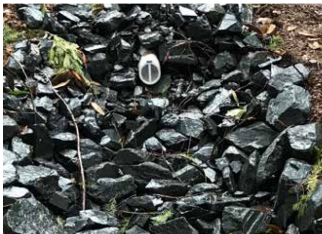
Figura 5-10: Descarga del desbordamiento sobre ripio con malla de desagüe instalada (Fuente: Distrito de Conservación de Recursos de Sonoma)
