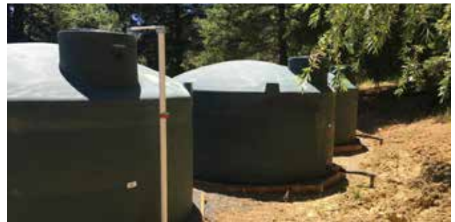
Figura 1-10: Tanques en plataformas de grava (Fuente: Distrito de Conservación de Recursos de Sonoma)
