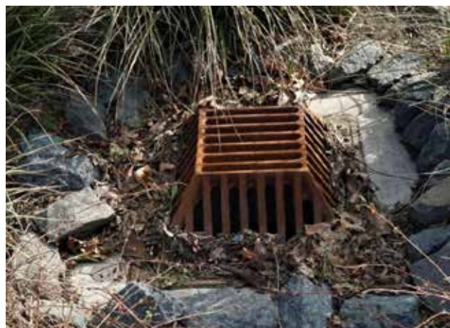
Figura 5-11: Unidad Bubble Up en un jardín de lluvia (Fuente: stormwater.cob.org )
