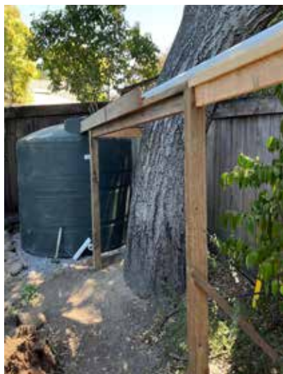
Figura 4-14: Tubería horizontal de transporte de línea seca soportada a tanque (Fuente: Sebastian Bertsch)
