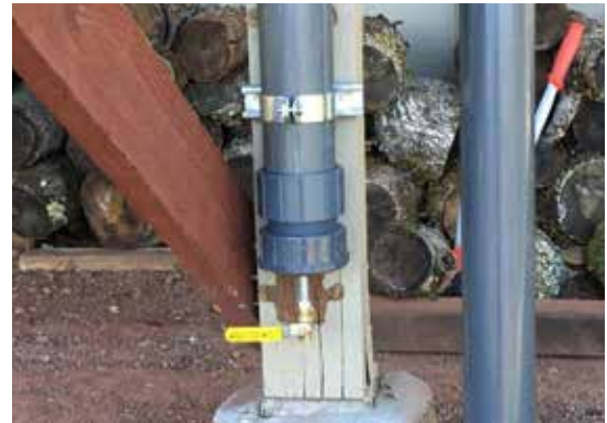
Figura 4-10: Válvula de drenaje manual en el sistema de primeras aguas, se puede dejar abierta para que gotee lentamente (Fuente: Distrito de Conservación de Recursos de Sonoma)
