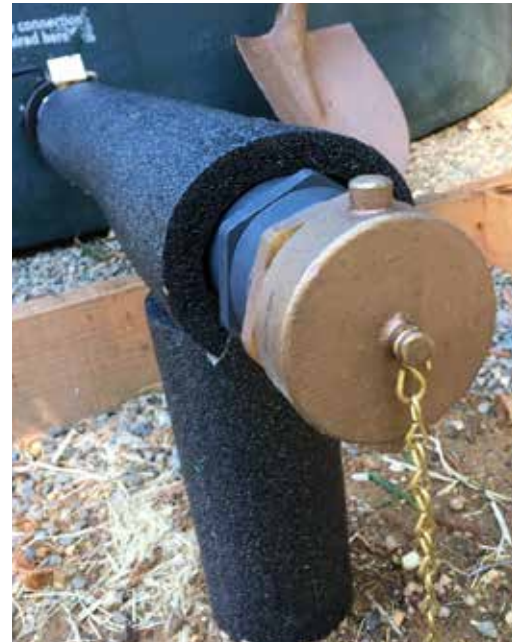
Figura 6-3: Conexión típica de manguera contra incendios (Fuente: Distrito de Conservación de Recursos de Sonoma)
