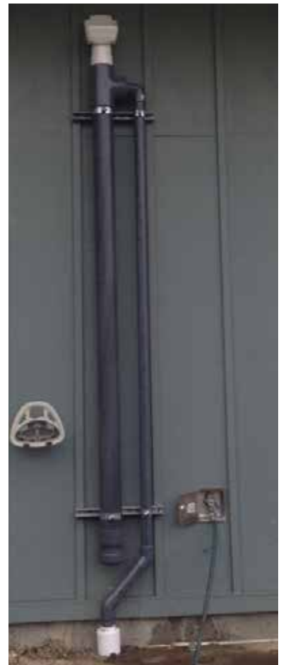
Figura 4-8: Sistema de primeras aguas con tubería de transporte a la derecha (Fuente: Distrito de Conservación de Recursos de Sonoma)
