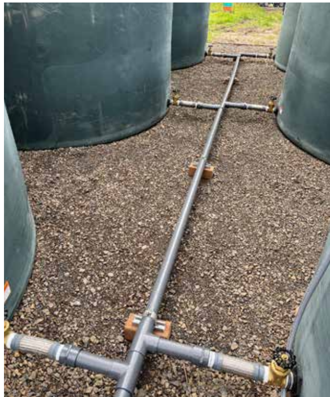
Figura 3-8: Tanques múltiples en la misma elevación (Fuente: Distrito de Conservación de Recursos de Sonoma)
