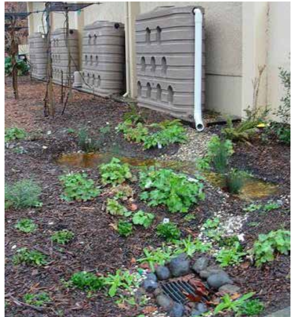
Figura 1-14: Tubería de rebose que llena el jardín de lluvia antes de la entrada de desagüe existente (Fuente: Daily Acts)
