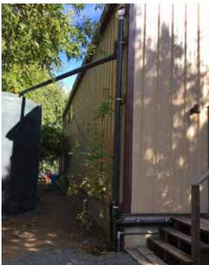
Figura 4-13: Línea seca y sistema de primeras aguas (Fuente: Distrito de Conservación de Recursos de Sonoma)
