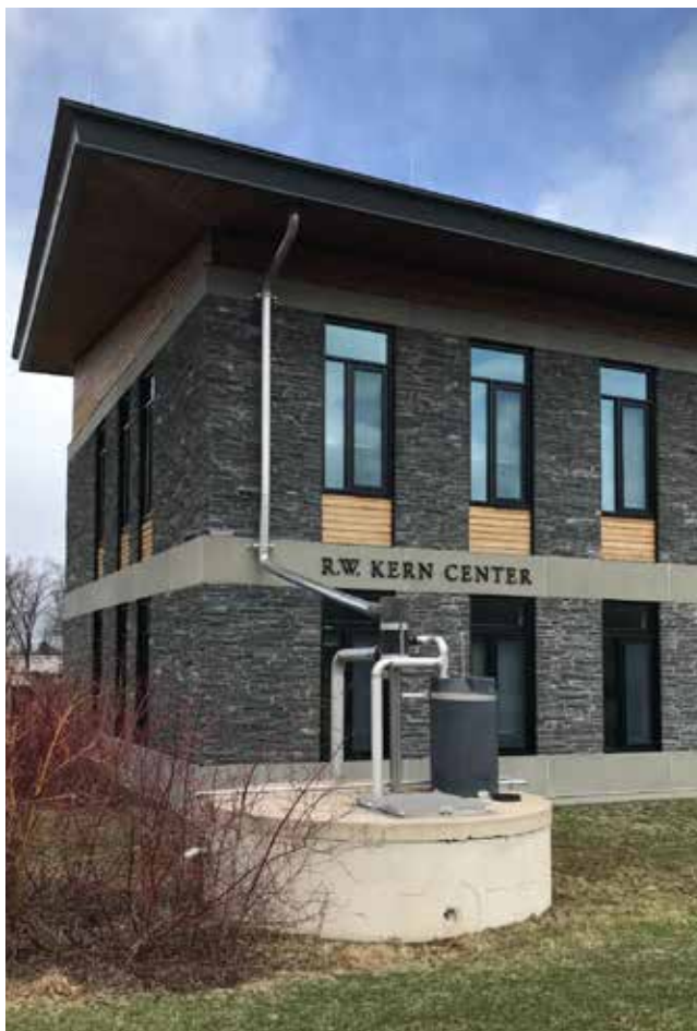
Figura 1-8: Tanque por debajo del nivel del suelo con conducción por línea seca (Fuente: Sebastian Bertsch)
