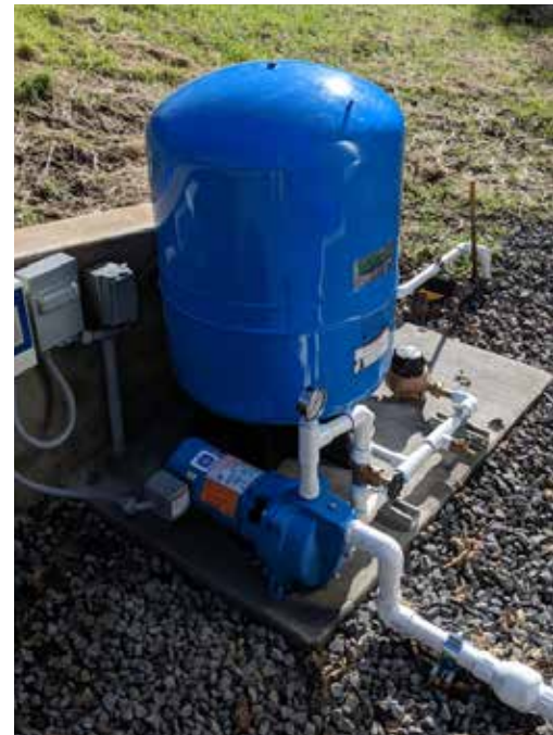
Figura 6-5: Bomba de refuerzo sobre el suelo y tanque de presión (Fuente: Distrito de Conservación de Recursos de Gold Ridge)
