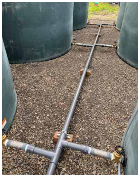
Figura 6-1: Tanques con manifold, conexiones flexibles y válvulas de cierre (Fuente: Distrito de Conservación de Recursos de Sonoma)
