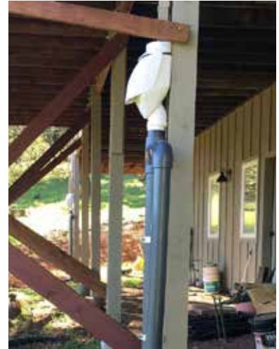
Figura 4-8: Sistema de primeras aguas con tubería de transporte a la derecha (Fuente: Distrito de Conservación de Recursos de Sonoma)
