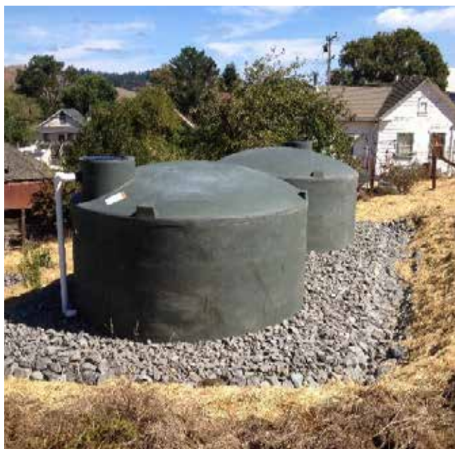
Figura 1-7: Tanques de HDPE de 5,000 galones con conducción por línea húmeda (Fuente: Distrito de Conservación de Recursos de Gold Ridge)
