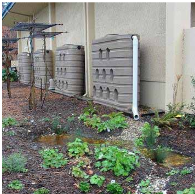
Figura 1-6: Tanques Slimline de HDPE con conducción por vía seca (Fuente: Daily Acts)
