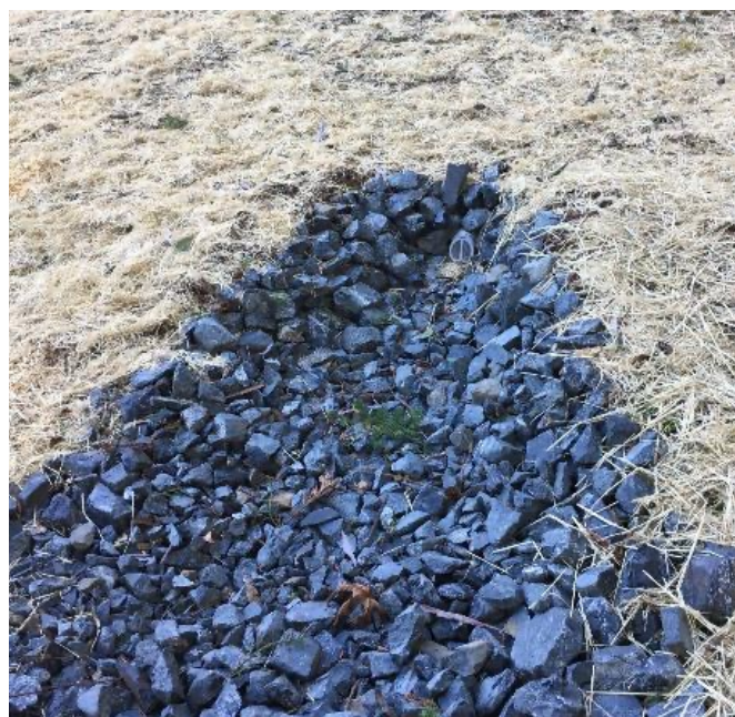
Figura 3-10: Disipador de rebose estable, protegido por roca (Fuente: Distrito de Conservación de Recursos de Sonoma)
